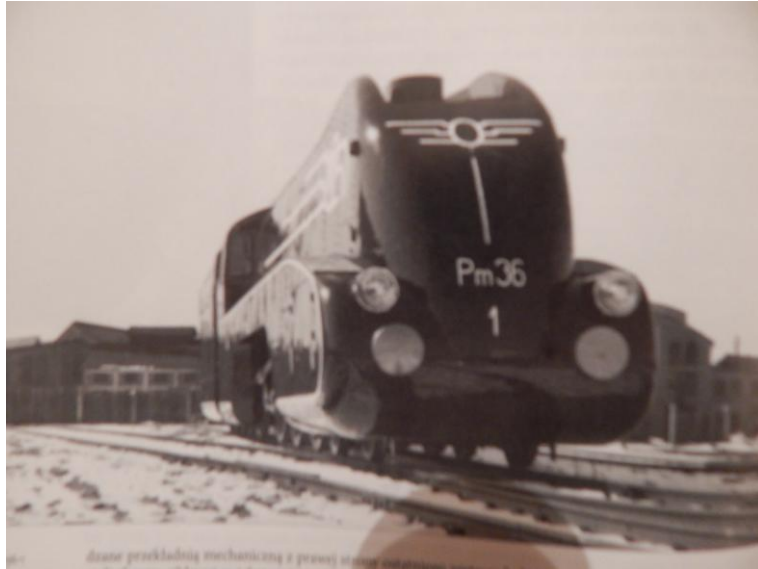
Zdjęcie 3. Parowóz Pm 36-1 w otulinie aerodynamicznej na terenie „Fabloku”
